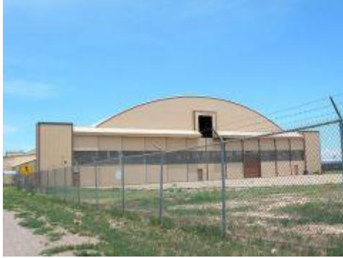
Le hangar 84 sur la base de Roswell aujourd'hui
